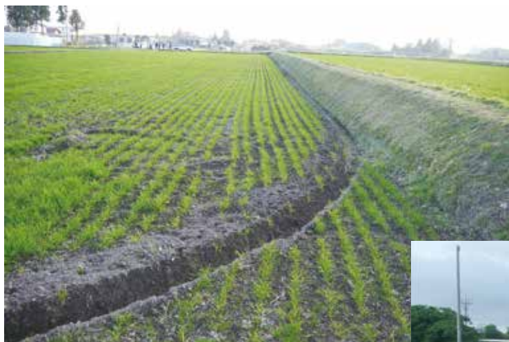
写真1 明渠の施工状況
